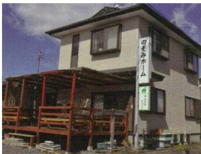
17 「みんなのハウス」(もくれんカフェ) 外観
